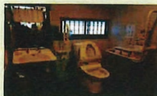
(5)車いす使用者用便房への改修
